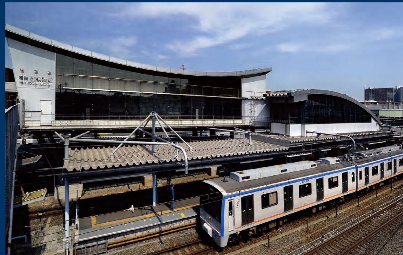
西横浜駅改良工事 発注者:相模鉄道(株)
