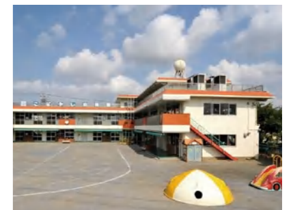
こばやし幼稚園改造防音工事 発注者:学校法人 秋葉台学園
