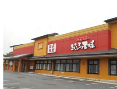
おふろの王様 町田店改装工事 発注者:東京建物リゾート(株)
