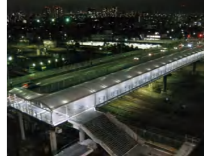
新鶴見機関区構内鹿島田こ線 人道橋新設その他(橋面)工事 発注者:東日本旅客鉄道(株)
