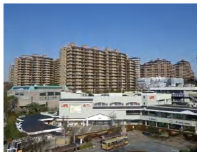
サン・ステージ緑園都市西の街 第2回大規模修繕工事 発注者:サン・ステージ緑園都市西の街管理組合
