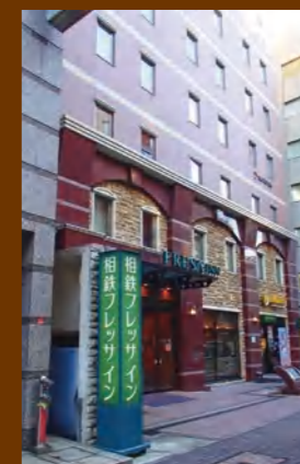
相鉄フレッサイン日本橋茅場町 内外装改修工事 発注者: (株)相鉄ホテル開発
