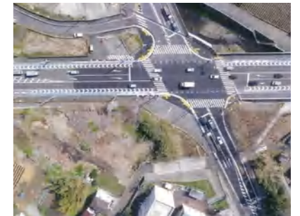
市道と泉町第449号線道路改良工事 発注者:横浜市
