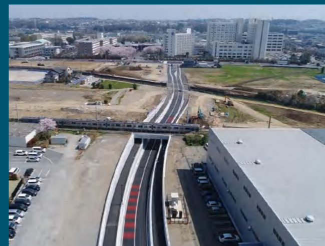
市道53号線バイパス道路新設工事(その1) 発注者:海老名市
