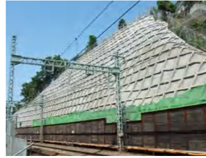
井土ヶ谷駅~弘明寺駅間 上下線吹付法面防護工事 発注者:京浜急行電鉄(株)
