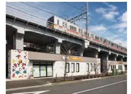
大井町線大井町駅~下神明駅間高架下店舗 発注者:東京急行電鉄(株)
