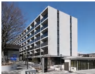
KNOCKSみなまきみらい 発注者:相鉄不動産(株)
