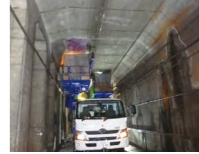
コンクリート構造物中性化対策工事 (万騎が原トンネル・土木関係) 発注者:相模鉄道(株)
