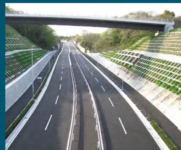
都市計画道路戸塚遠藤線街路整備工事 発注者:横浜市
